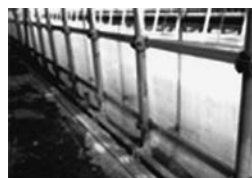
沈下防止パイプによる固定
