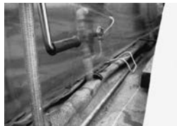
カーテン裾部の隙間
