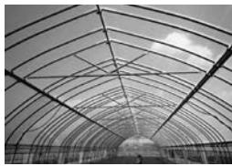
タイバーによる補強
