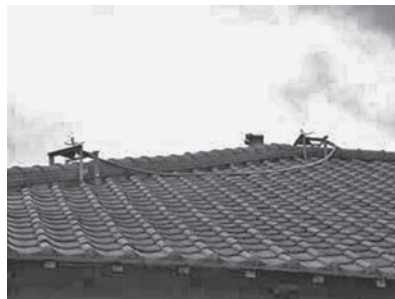
スプリンクラーの設置
