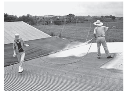
屋根・壁に石灰乳の塗布
